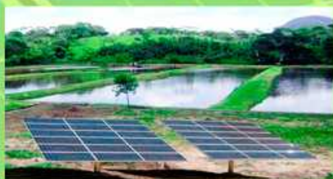
Sistemas de autoconsumo para aireación, bombeo y recirculación piscícola.
